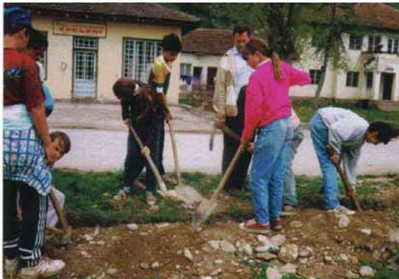
Радна акција на прокопавању канала за телефон ( 1997. )
